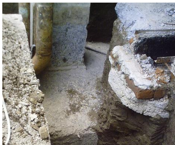
Figura 3.4. Pozo a cielo abierto para determinar dimensiones de la fundación de una columna
