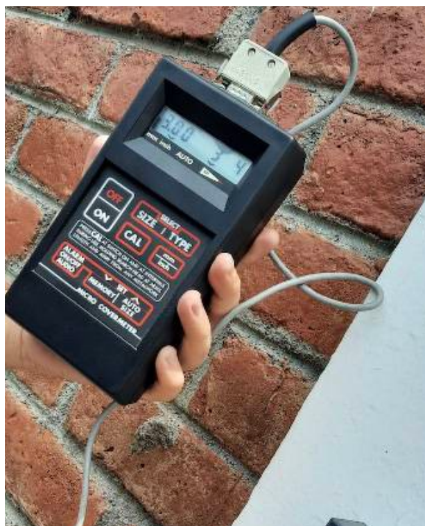
Figura 3.3. Exploración no destructiva en un nervio de concreto reforzado
