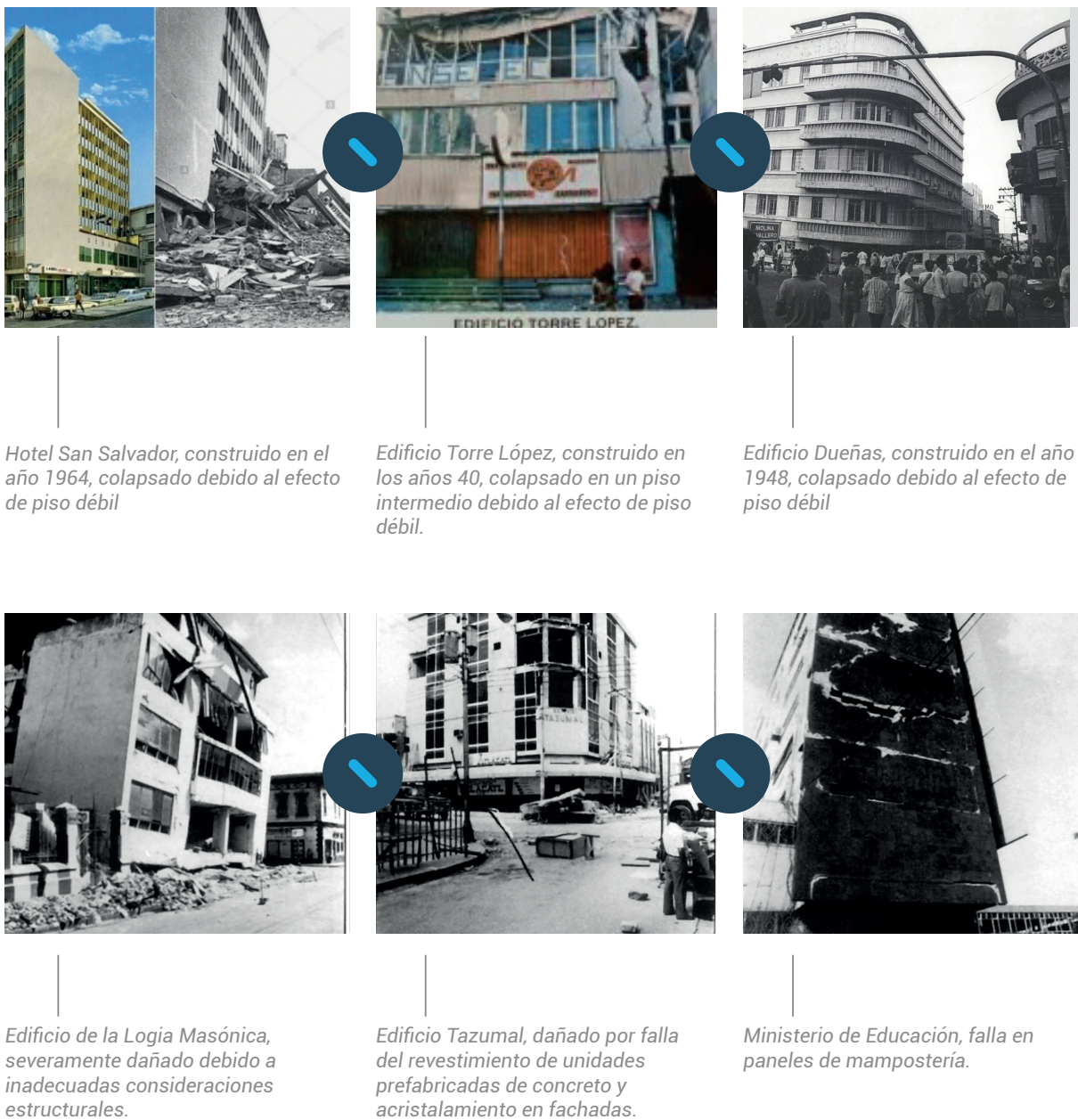
Figura 7: Vulnerabilidad y daños observados en edificaciones en el terremoto de 1986. Fuente: The San Salvador Earthquake of 10 October 1986 – A Field Report by EEFIT, 1987. LPG (Archivo).
