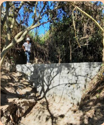
MURO MR2: construido con piedra, ladrillo u otros materiales similares, esto se conoce como mampostería.
