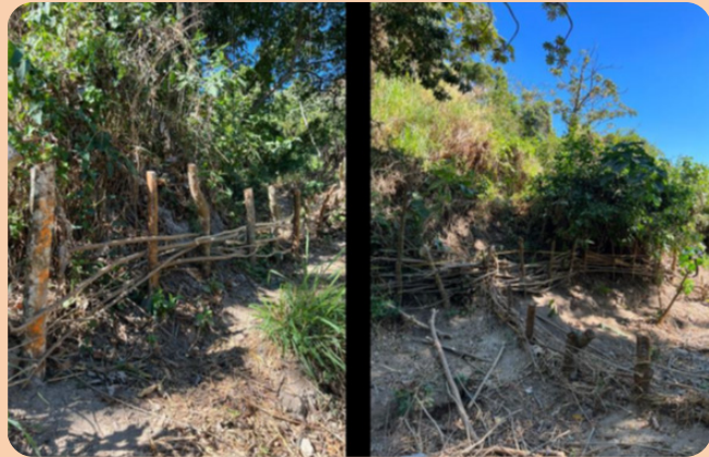
Muro MR1: medidas con elementos ecológicos o barreras vivas. Estos se conocen como Bioingeniería. Se han realizado obras de bioingeniería.
