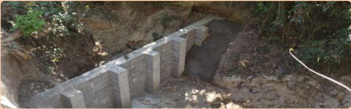
MURO MR4: con estructuras formadas de una mezcla de lodo y concreto para proporcionar estabilidad y resistencia adicional a los lados del muro.
