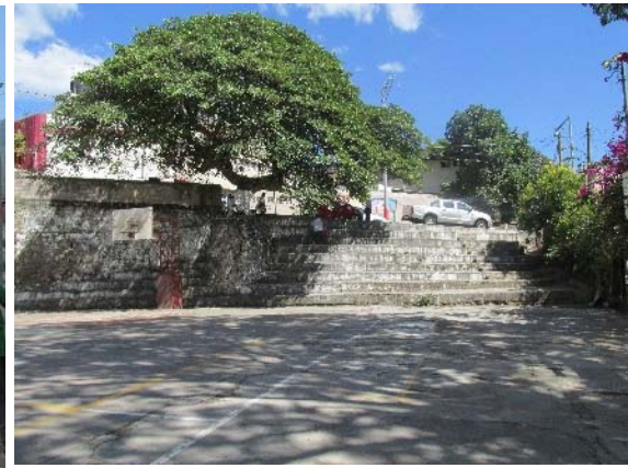
Falta de accesibilidad al espacio publico
